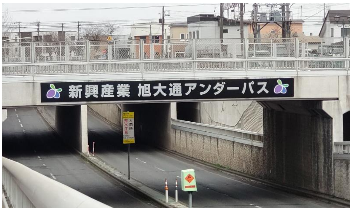
工事完了後の新興産業旭大通アンダーパス南（若草町4丁目）側
